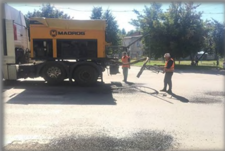
Ямковий та поточний ремонт в асфальтному покритті
