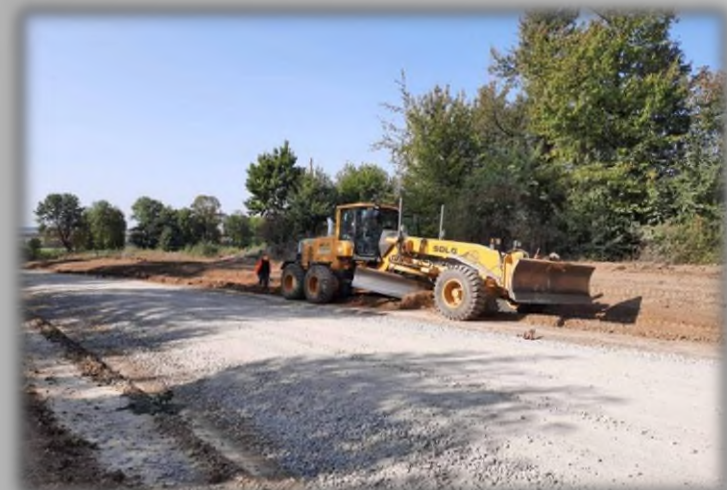
Грейдерування та щебенеve покриття
