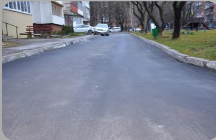
Здійснено капітальний ремонт тротуарів по вул. Київська, 24, вул. Шевченка до вул. Конституції, вул. Дунайгородська, вул. Лендера Франца (825,9 тис. грн).
