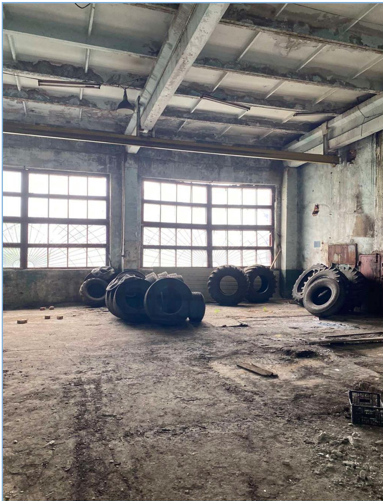
Рис. 4 Приміщення ТДВ «Ремонтно-механічний завод» (всередині)
