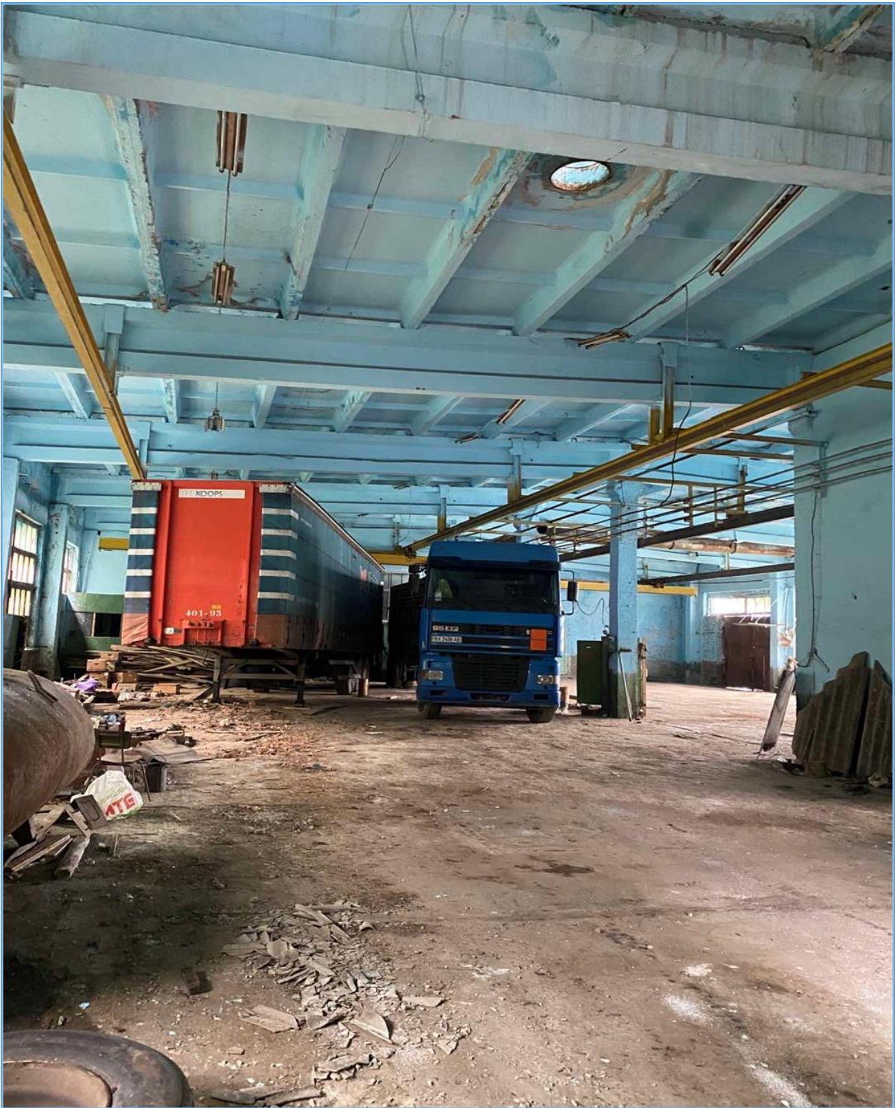
Рис. 5 Приміщення ТДВ «Ремонтно-механічний завод» (всередині)
