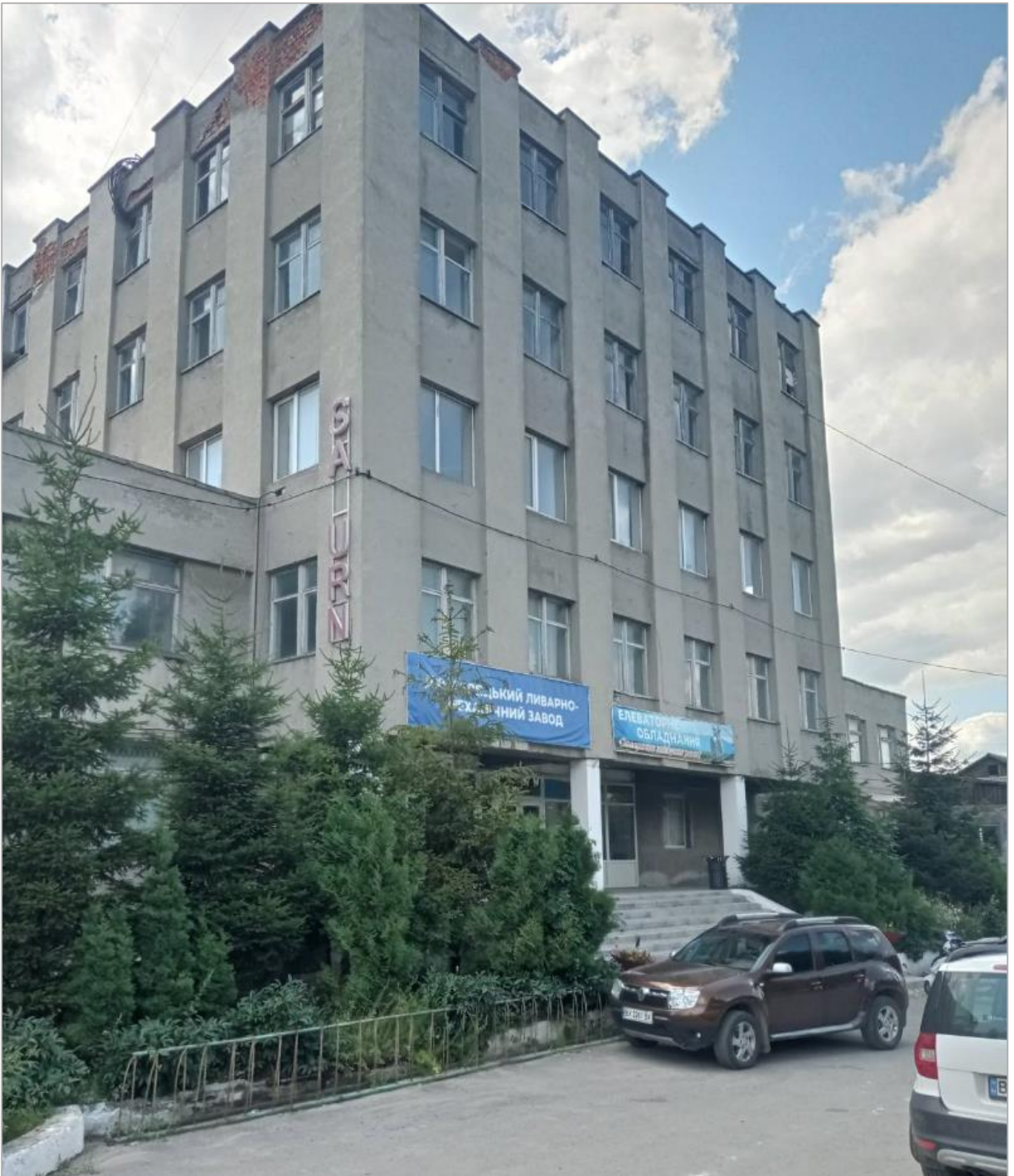
Рис. 2 Приміщення корпусу ТОВ «Дунаєвецький ливарно-механічний завод»
