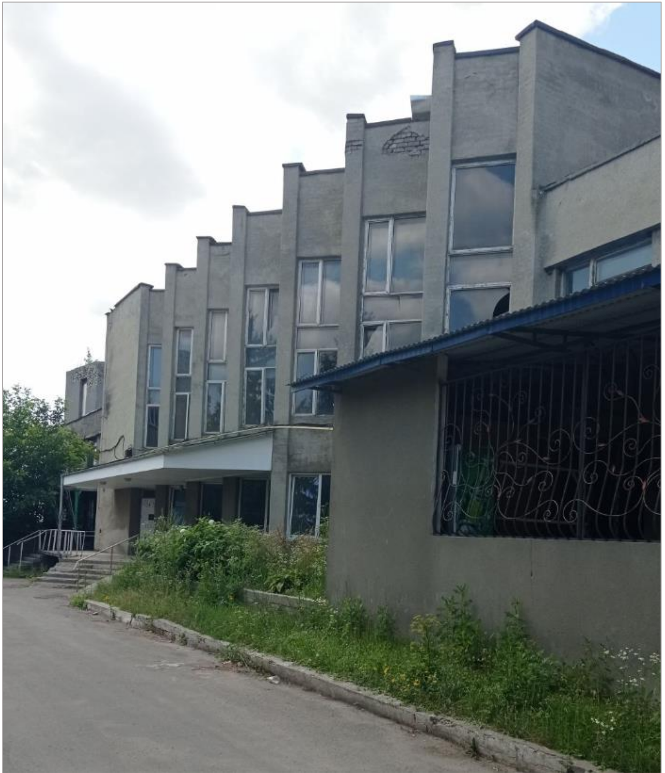
Рис. 3 Приміщення корпусу ТОВ «Дунаєвецький ливарно-механічний завод»
