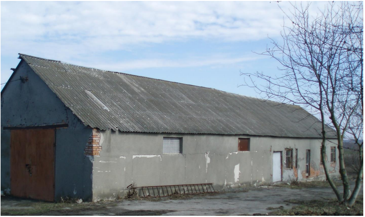
Рис. 10. Фото нежитлової будівлі (цех з переробки кісток)
